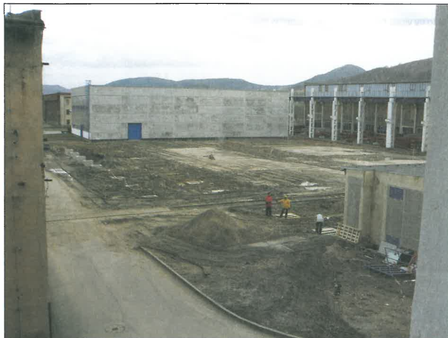
Tosácké staveniště má konkrétní tvář. Většina patek je zabetonována (fotografie je z 22. ledna 2007). Do července by tu již měla stát nová montážní hala.
