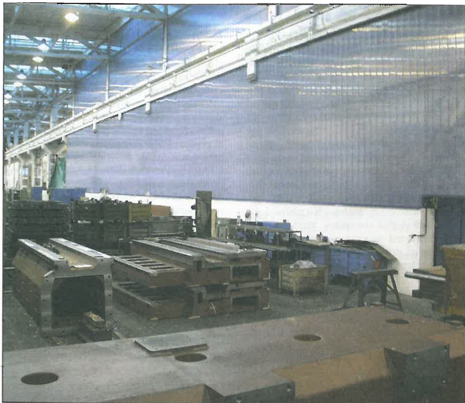
NOVINKY VE FOTOGRAFII: K novinkám, které v nedávné době přispěly ke zlepšení pracovního prostředí i estetického vzhledu našich pracovišť, patří dělicí stěna mezi montážemi a těžkou mechanikou.
